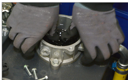
Obr. 242 Vložení nového filtru hydraulické nádrže
